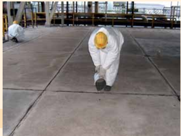
Das Gruneberg-Team beim Ausgießen von Fugen.
